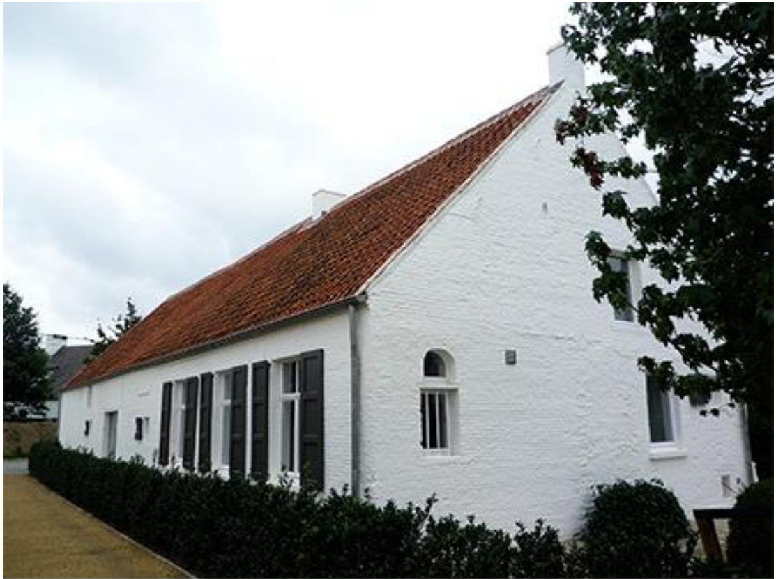
Figuur 5-74 Cretenburghoeve na restauratie (foto: arch. Beeck-Hermans)
