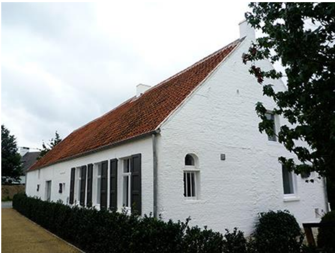
Figuur 5-74 Cretenburghoeve na restauratie (foto: arch. Beeck-Hermans)
