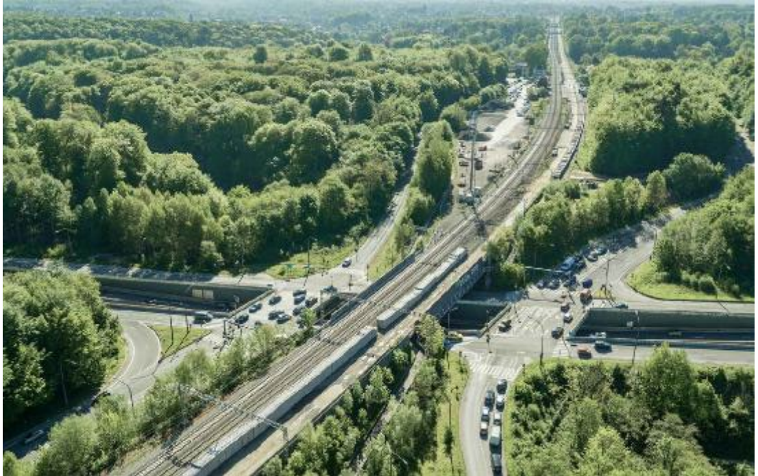
Figuur 12-4: Bestaande toestand t.h.v. knoop Groenendaal vanuit het westen (bron: nota ontwerp onderzoek)
