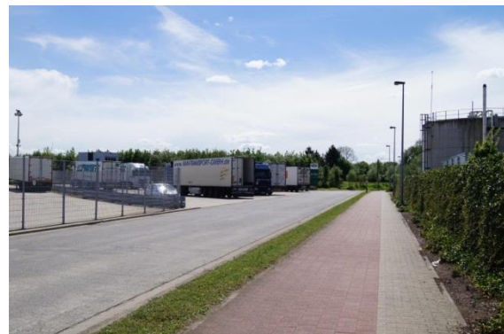
Een zicht vanuit de Astridstraat richting voorziene uitbreiding. Rechts op de foto is het waterzuiveringsstation te zien.
