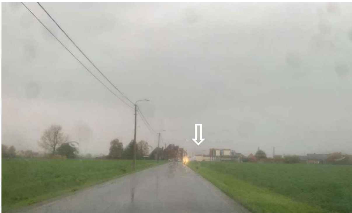
Figuur 10-63 Diepvriesgebouw Agristo Wielsbeke november (bron: eigen materiaal)
