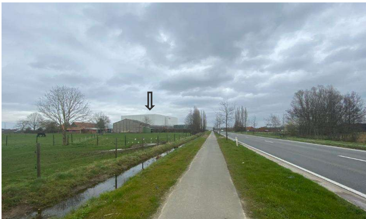
Figuur 10-62 Diepvriesgebouw Agristo Wielsbeke (bron: eigen fotomateriaal)
