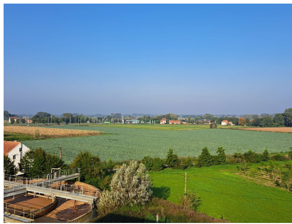
Foto van waterzuivering (3) vanop restromengebouw
