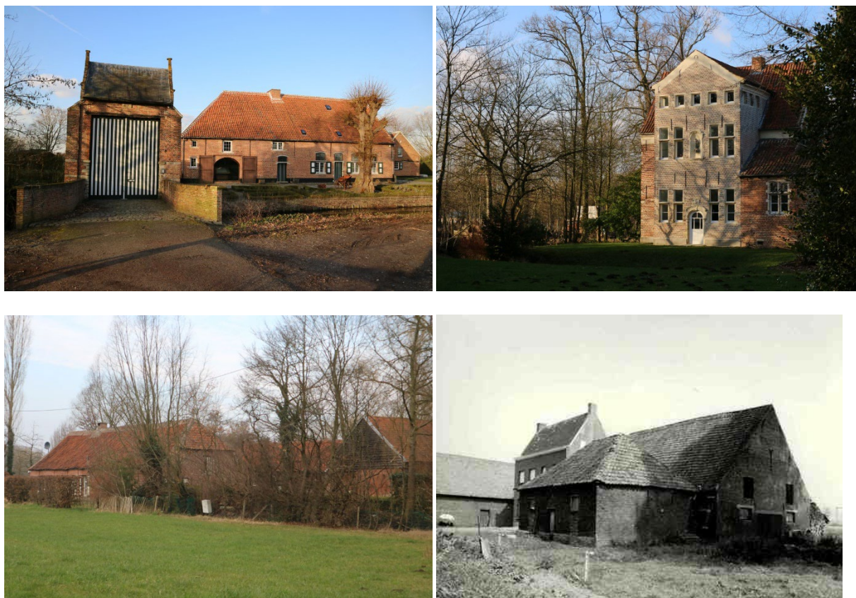
Figuur 50. Hoeves met bouwkundig erfgoedwaarde: Kartuizerhoeve, Jezuïetenhoeve, Hoeve Ter Haegen en hoeve met losse bestanddelen (Beeldbank Agentschap Onroerend Erfgoed, Michael Van Craen)
