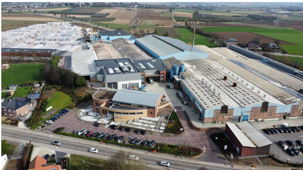
Figuur 15: Vandersanden steenfabrieken vanaf de Riemsterweg met links achteraan de uitbreiding ter hoogte van het deelgebied Vandersanden omstreeks eind 2024
