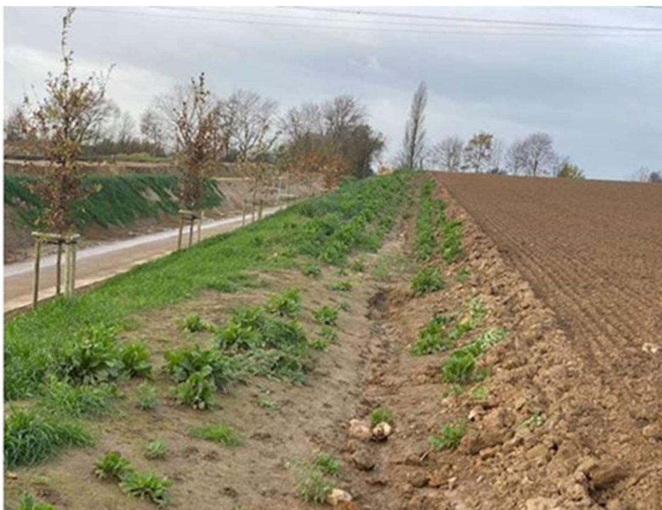
Figuur 11: Verlegde Schildstraat (holle weg) en bufferstrook van 3 m met gracht om erosie tegen te gaan.
