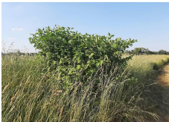
Figuur 4-77 Japanse duizendknoop op de waterkerende dijk
