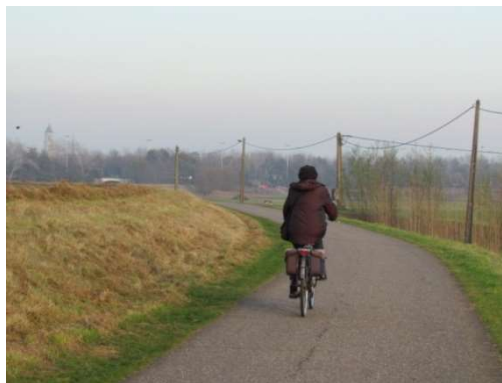
Noordelijke weg in dijkhelling
