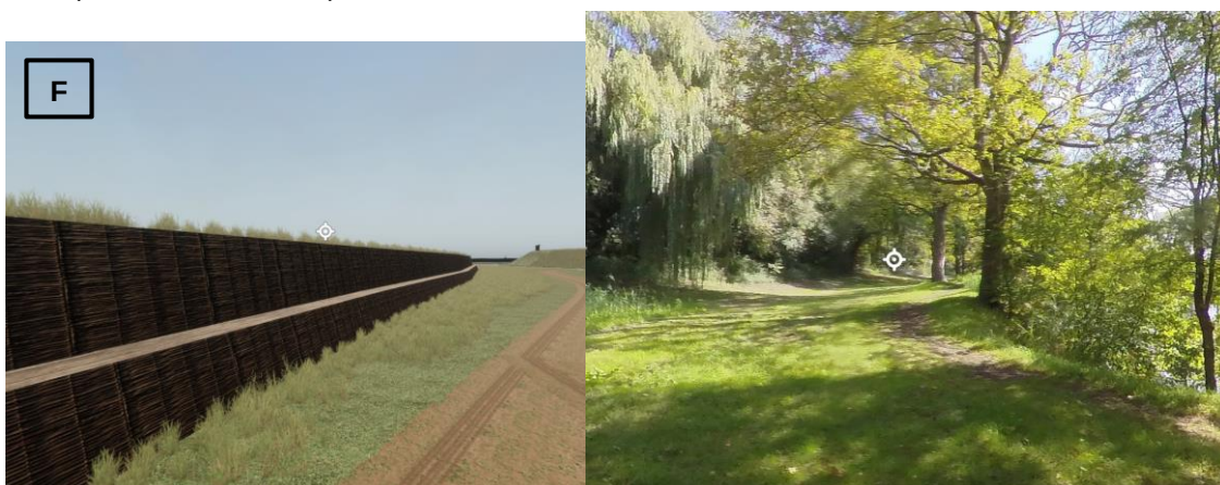
Figuur 8-28: Boven op de vesten ter hoogte van de noordelijke poterne (links: virtuele reconstructie ca. 1640; rechts: ca. 2022)
