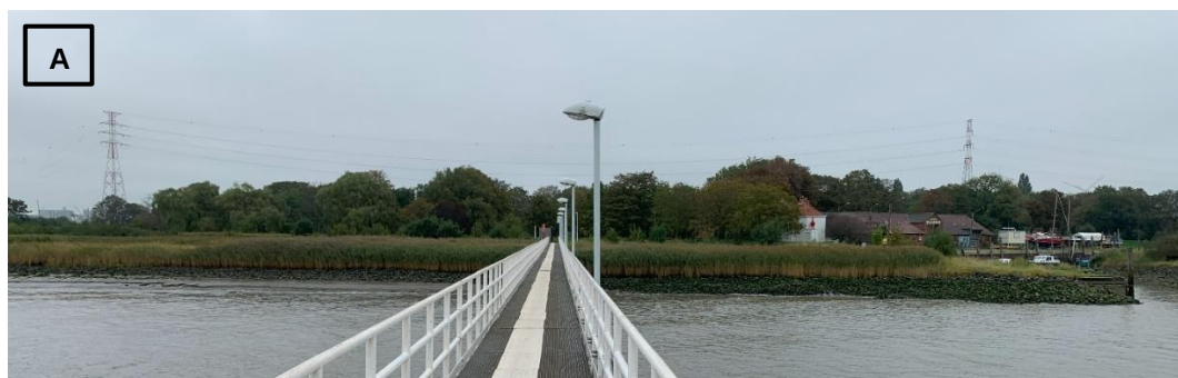
Figuur 8-23: Steenbestorting langs de waterrand in de referentiesituatie (Terreinbezoek 2/10/2024)
